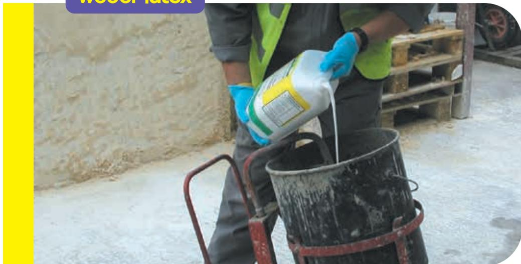
Yüksek nitelikli sıva ve harç elde etmek, aderans köprüsü oluşturmak, su geçirimsizliği ve elastikiyeti artırmak amacıyla kullanılan özel katkı malzemesi.
