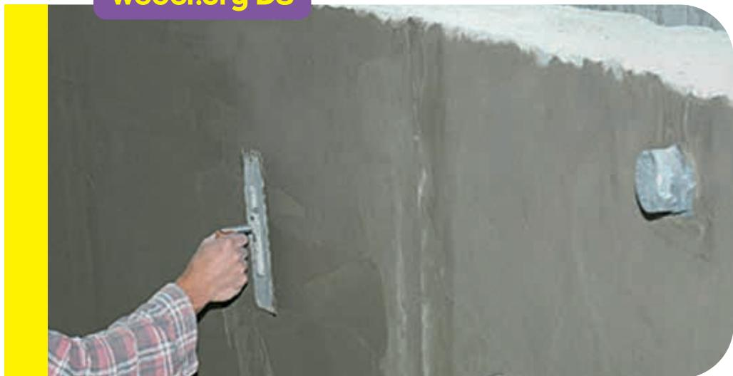
Çimento esaslı, negatif ve pozitif su basıncına dayanıklı, çimento esaslı yüzeylerin kapiler boşluklarına transfer olabilen, tek komponentli, kristalize su yalıtım harcı.
